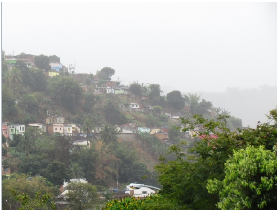
Figura 2.33: Área com risco de deslizamento Fonte: MJ Engenharia (2013)
